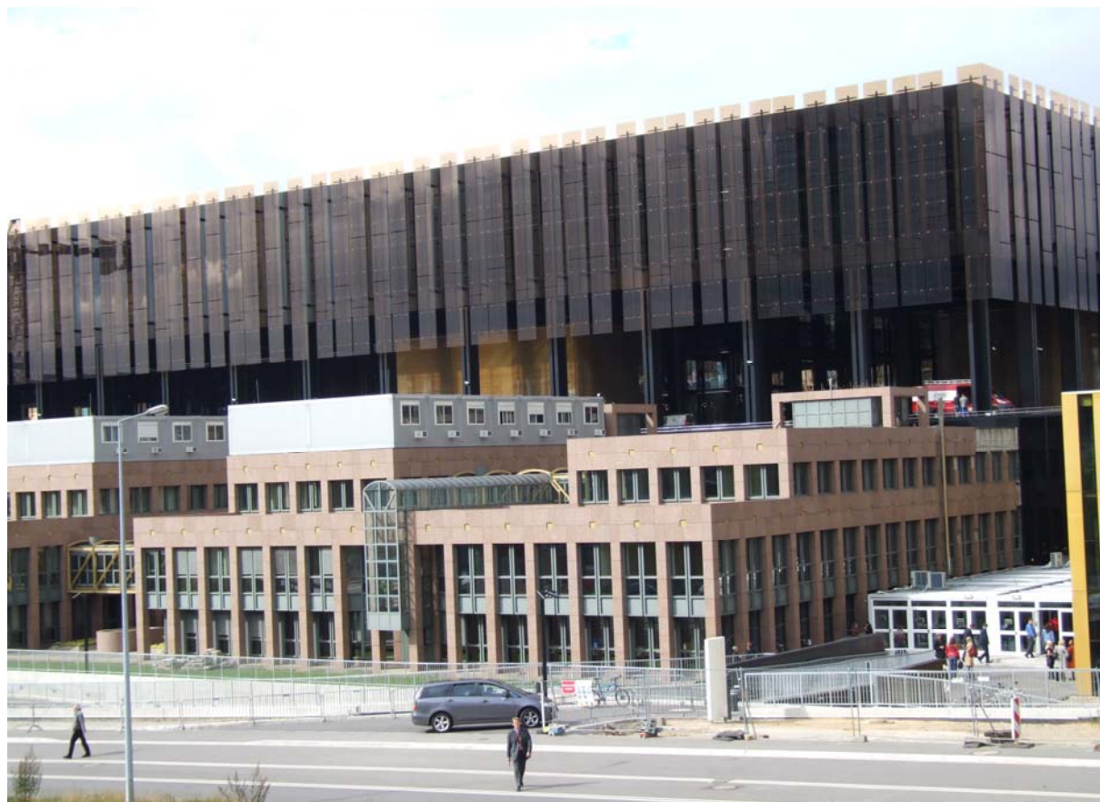
Hlavní budova Soudního dvora EU, v níž se nacházejí soudní síně
